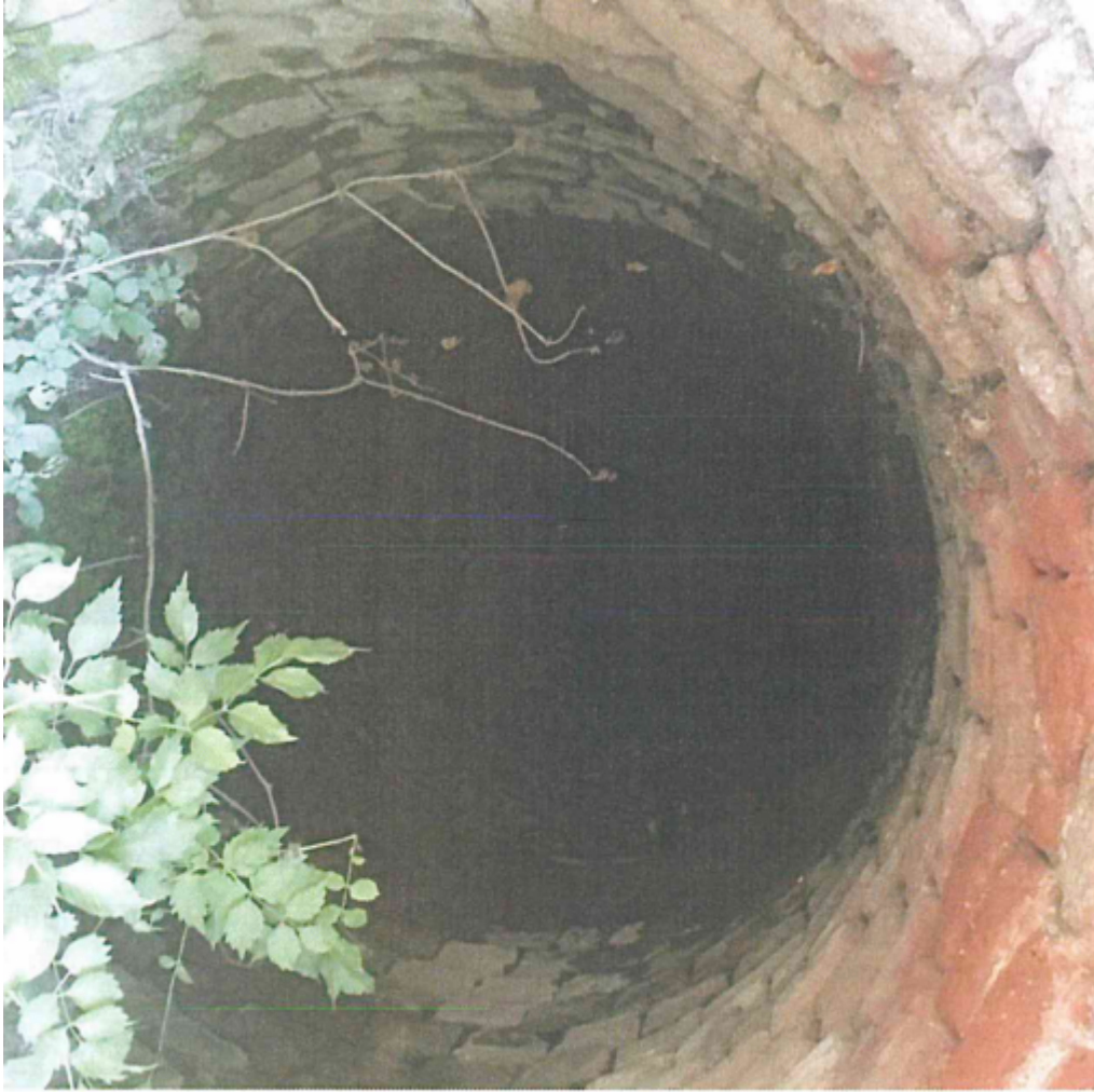
Immagine tratta dalla videoispezione del pozzo
